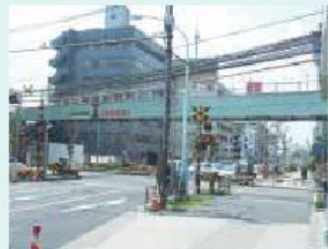
工事が進む環状8号線仮高架橋
